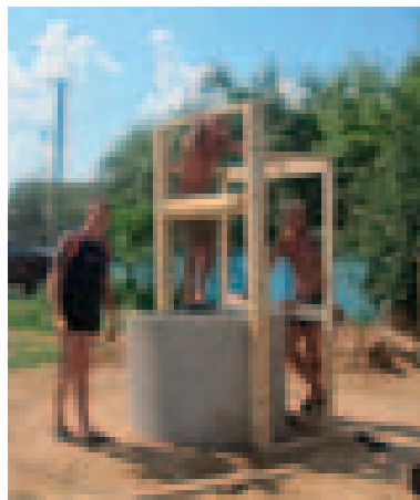
СТРОИТЕЛЬСТВО КОЛОДЦА В ГРИГОРЬЕВСКОМ
